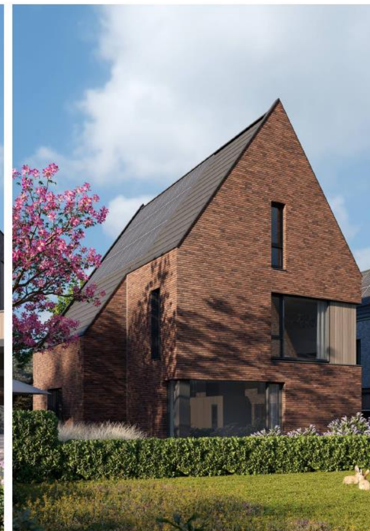
Een compact volume, strakke consistente detaillering. De overhoekse raampartijen openen het volume.
