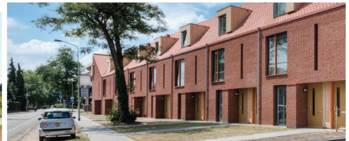
Plastiek in combinatie met materialisering. De houten voering in het terugliggende volume benadrukt 'een buiten en een binnen'. Voorbeeld van een dakkapel in een andere materialisering dan de gevel. De dakkapel staat niet op de gevel maar integreert in de gevel.
