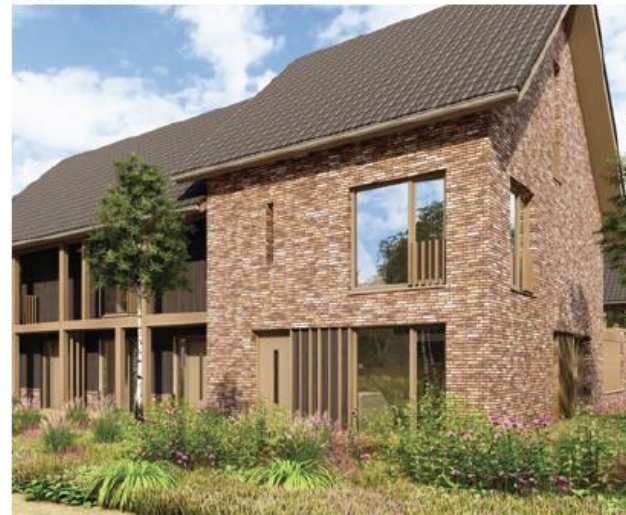
Strakke compositie van gevelopeningen en plastic. Door de terugliggende gevel ontstaat een overkapte buitenruimte als overgang tussen binnen en buiten. Zonder dakoverstek is compacter en sluit meer aan bij het gewenste beeld.
