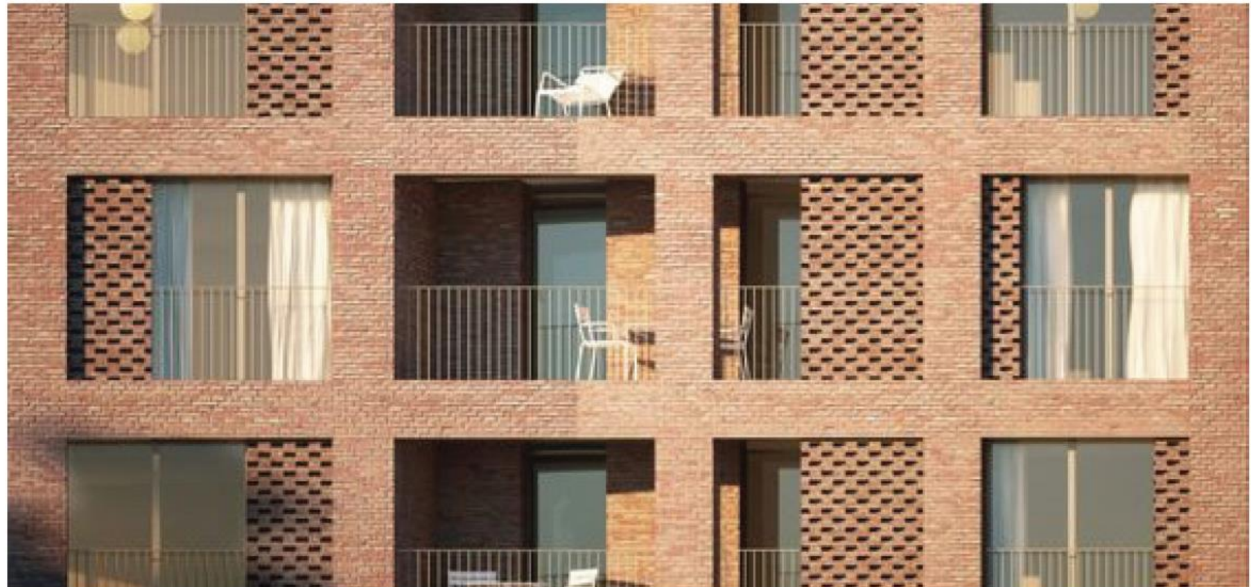
Voorbeeld van een raster met inpandige balkons en metselwerk puivullingen. De structuur leent zich goed voor de meer gesloten zijde in de buitenschil maar minder voor de naar de wijk toegekeerde zijde.
