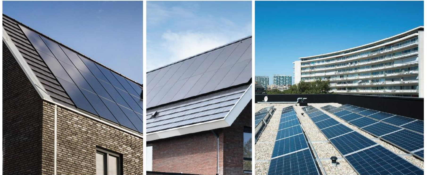
PV-panelen worden geïntegreerd in het dakvlak of op platte daken achter een dakopstand uit het zicht opgelost
