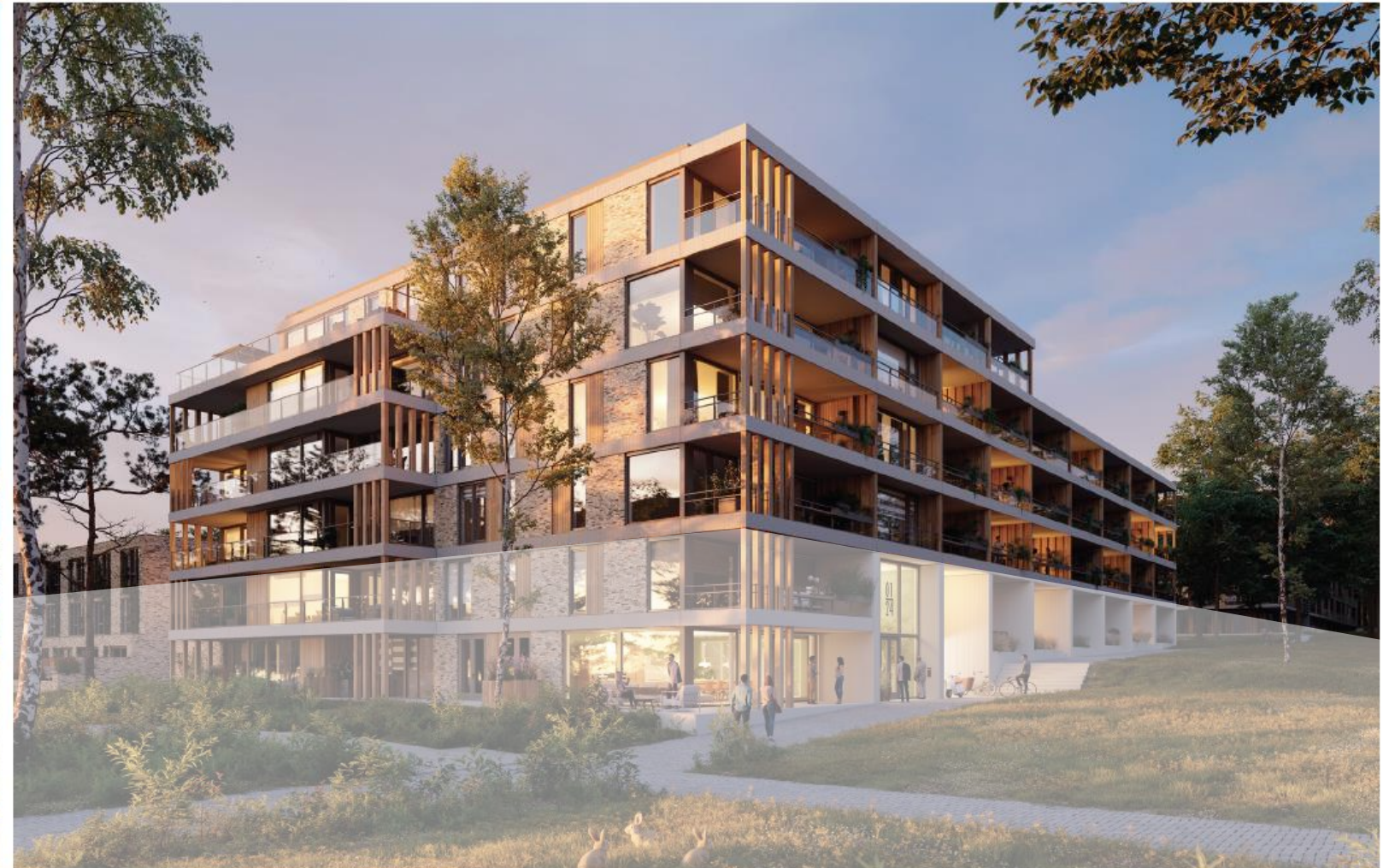
Voorbeeld koopappartementen. Door de combinatie van volledig uitkragende vloeren en het toepassen van lamellen en scheidingswanden toont het gebouw zich als volume met een terugliggende gevel.
